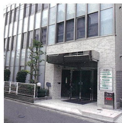
ビル正面玄関(事務所は3F)
